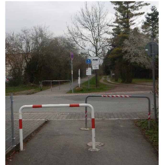
Bsp. P79 (Harxheim): Umlaufsperrren ersetzen
